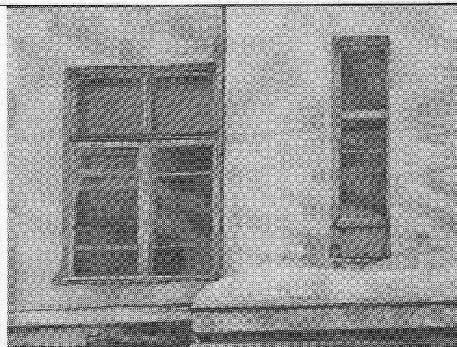
5.16. Первоначальные окна на дворовом фасаде
