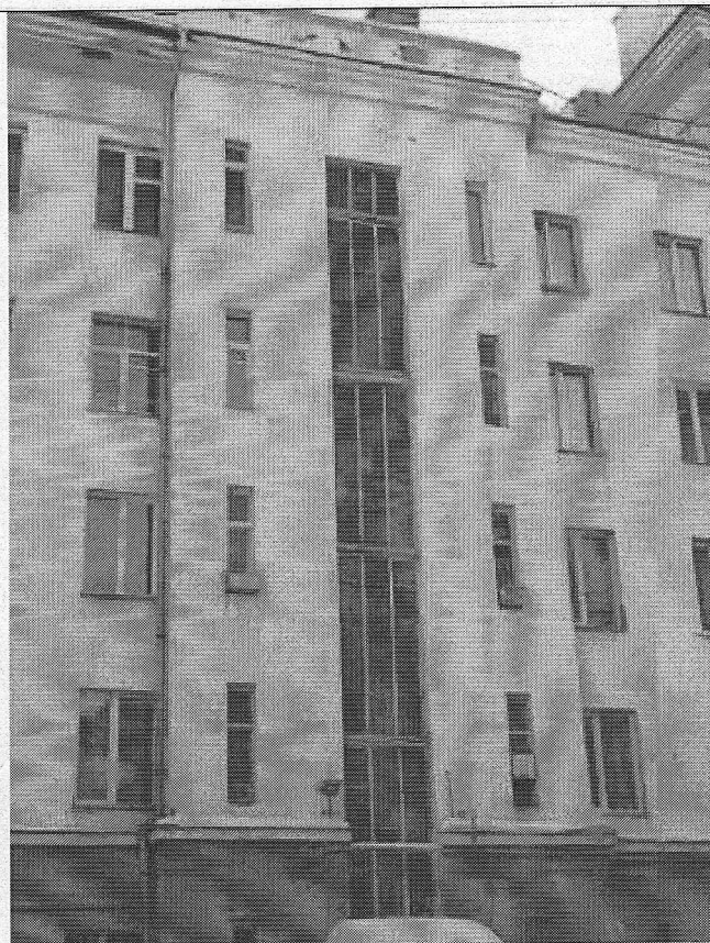
5.38. Первоначальные витражи лестничных клеток
