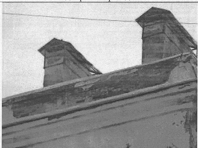
5.8. Вентиляционные шахты и парапет на дворовом фасаде
