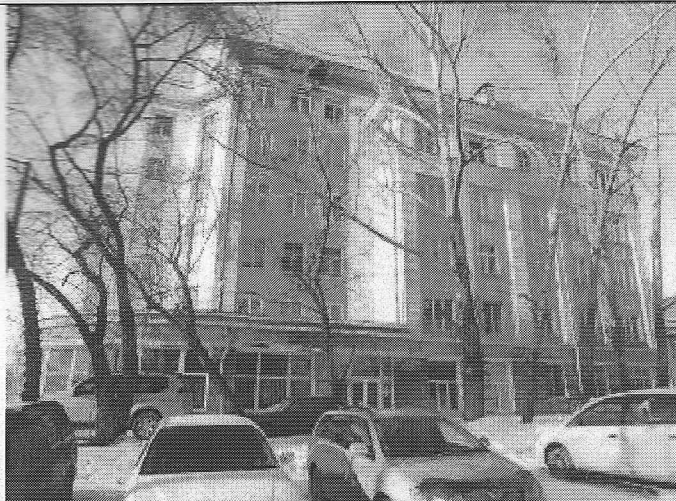
5.3. Юго-восточный уличный фасад
