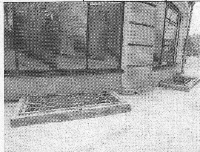
5.23. Световые приямки на главном фасаде
