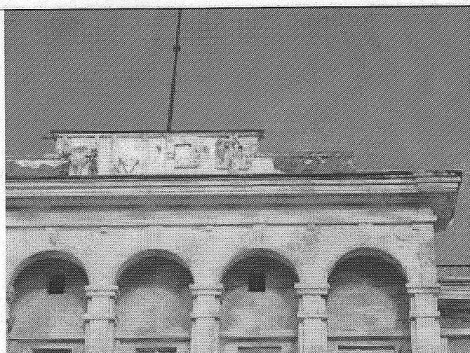
5.19. Центральный аттик и колоннада
