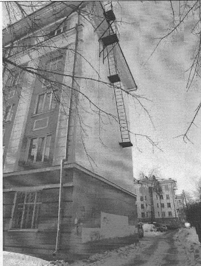
5.35. Пожарная лестница на торцевых фасадах
