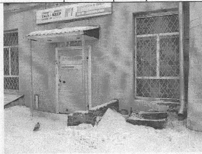
5.22. Фрагмент дворового фасада
