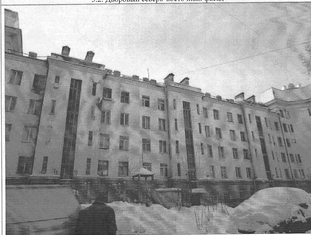
5.2. Дворовый северо-восточный фасад
