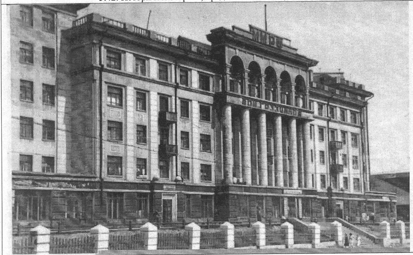
5.42. Историческое фото, предположительно, 50-е гг
