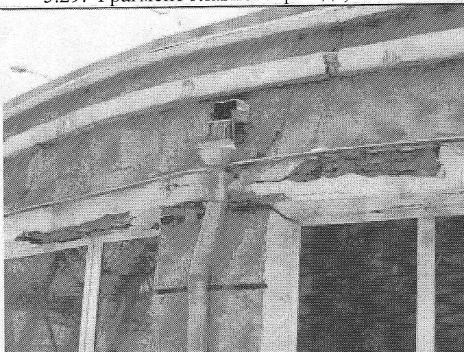
5.29. Фрагмент главного фасада, 1 этаж
