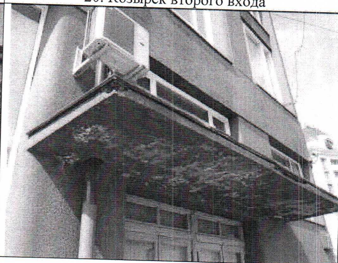
20. Козырек второго входа
