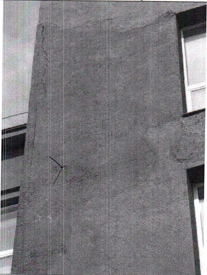
17. Фрагмент южного фасада
