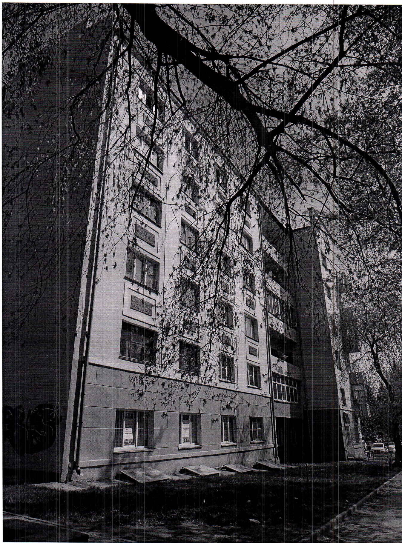
5.3. Вид западного фасада со стороны ул. Каменская.
