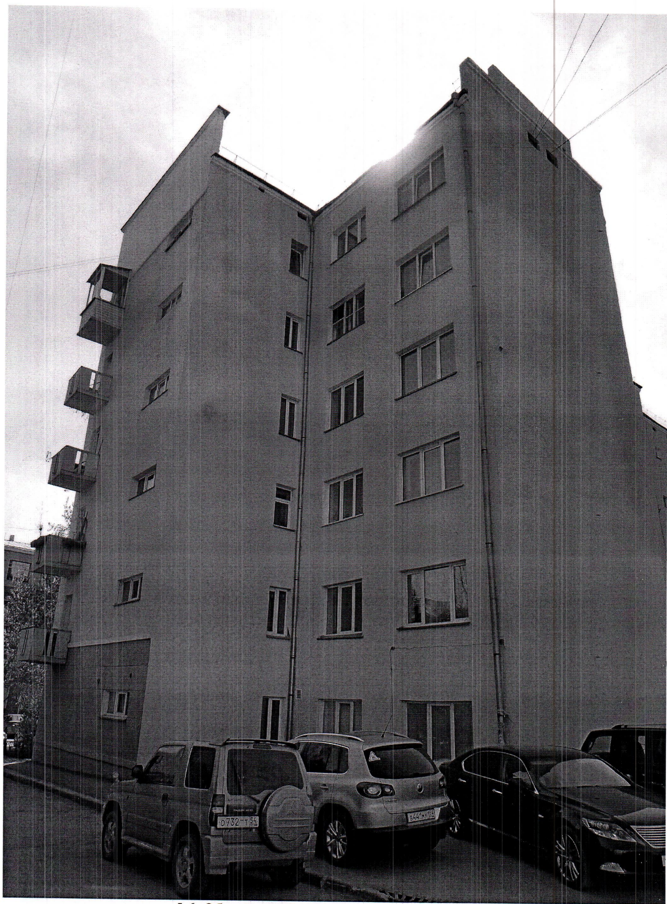
5.6. Общий вид бокового (восточного) фасада.
