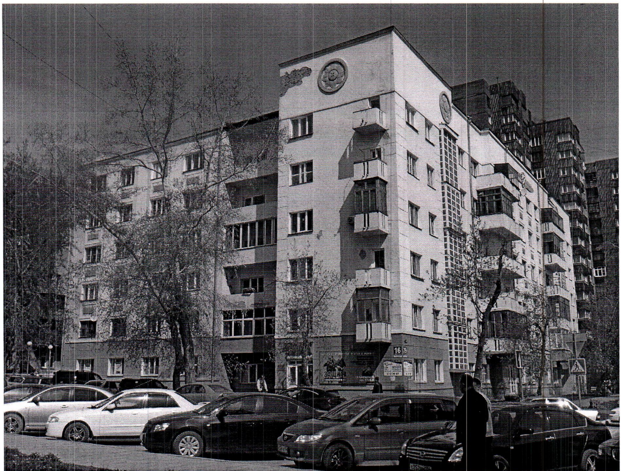
5.1. Общий вид главных фасадов.
