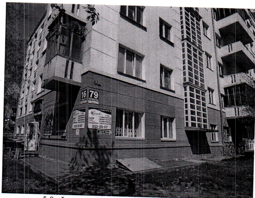
5.9. Фрагмент главного (южного) фасада. Размещение наружной рекламы.
