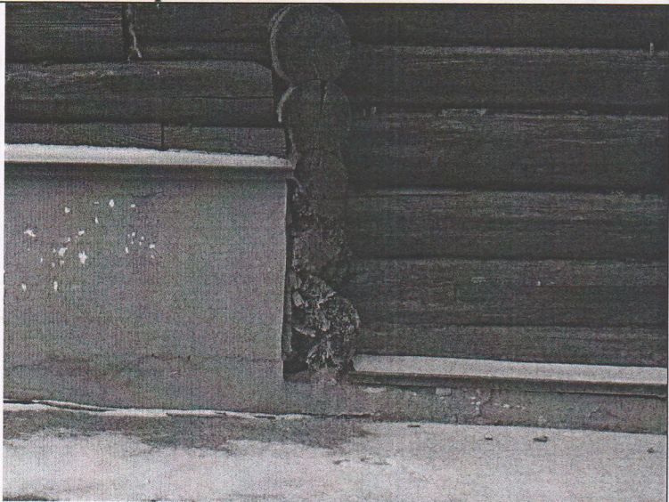
Фото № 5. Фрагмент бутового цоколя со стороны восточного фасада.
