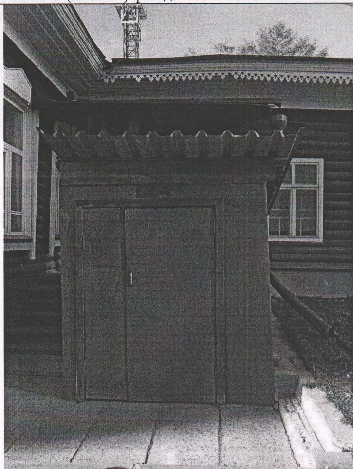
Фото № 16. Вход в цокольный этаж.
