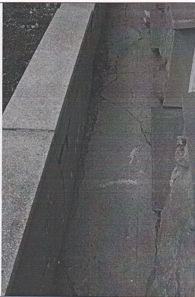
Фото № 6. Фрагмент приямка со стороны главного (южного) фасада.
