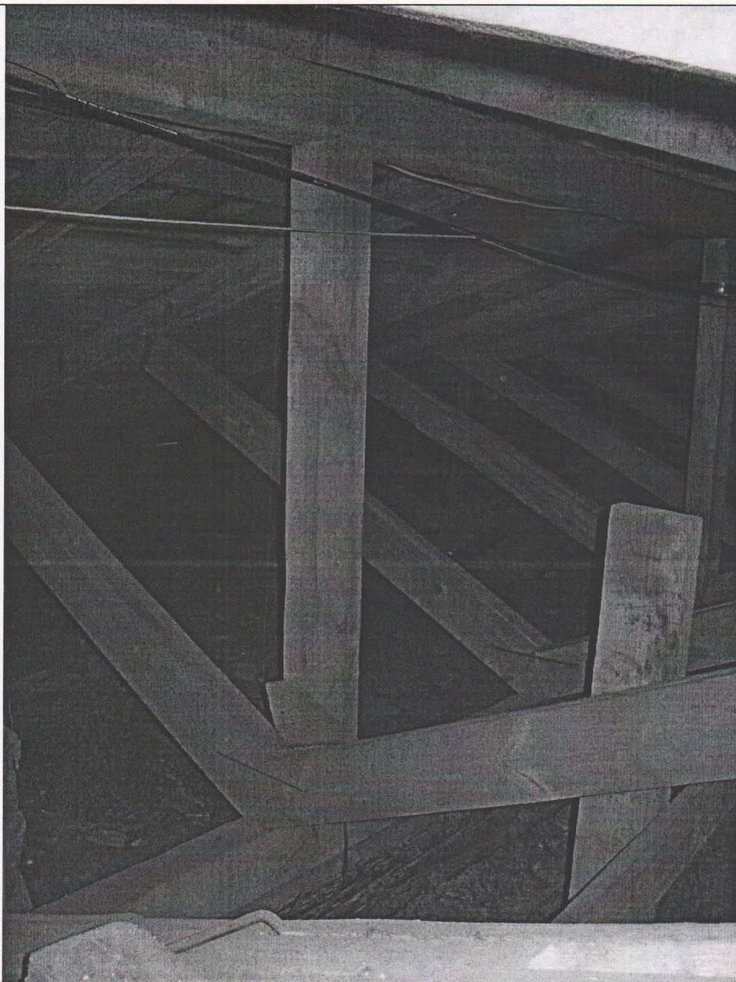
Фото № 9. Фрагмент чердачного помещения.
