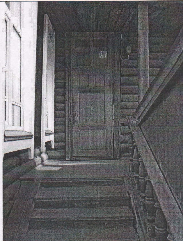
Фото № 15. Крыльцо и входная дверь со стороны восточного фасада.
