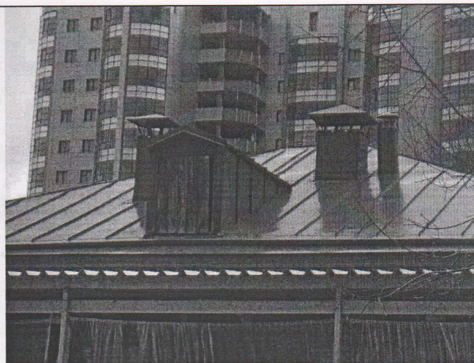
Фото 8. Фрагмент северного объема кровли со слуховым окном.
