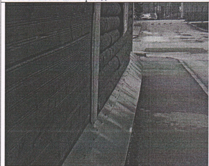
Фото 5. Фрагмент нижних венцов западной стены.
