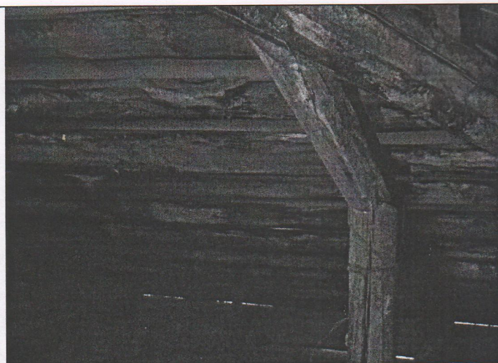
Фото 7. Фрагмент чердачного помещения.
