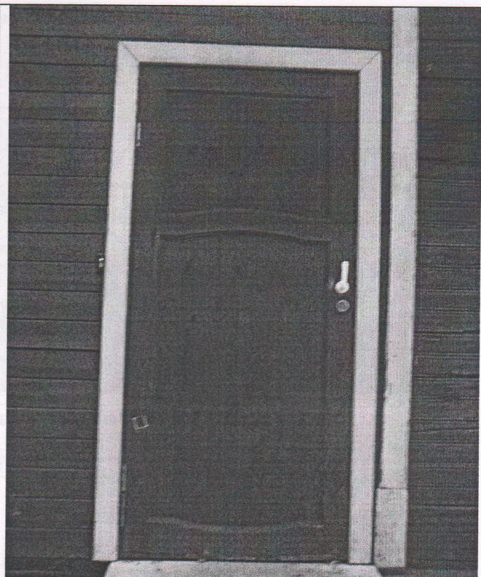
Фото 16. Входная дверь со стороны западного фасада.
