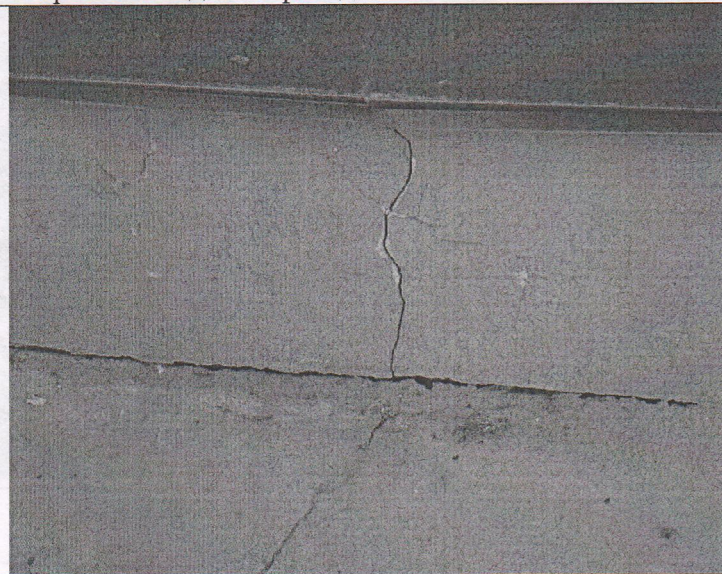
Фото № 6. Фрагмент цоколя и отмостки со стороны южного (главного фасада).
