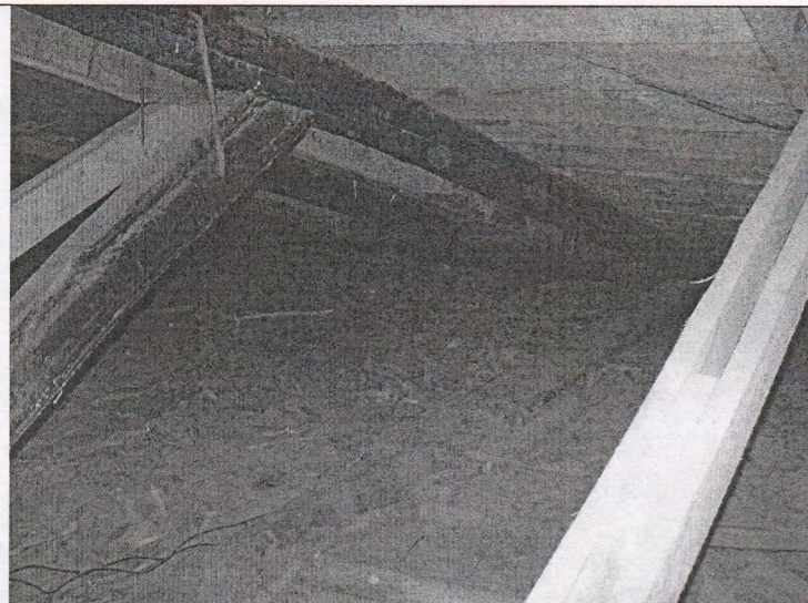
Фото № 8. Фрагмент чердачного помещения.
