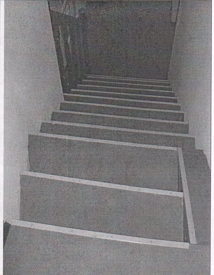
Фото № 19. Лестница между домами №№ 19 и 21.
