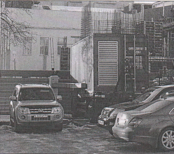
Фото № 20. Установка ДГУ.
