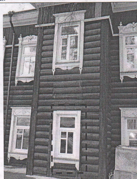
Фото № 17. Фрагмент северного фасада.
