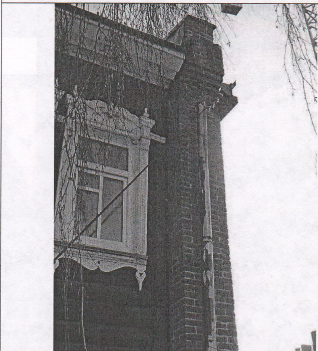
Фото № 10. Водосточная труба со стороны северо-западного угла Памятника.
