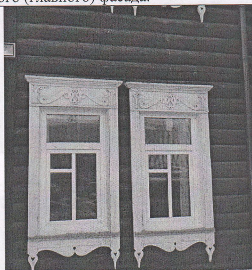
Фото № 15. Декор окон 1-го этажа северного фасада.
