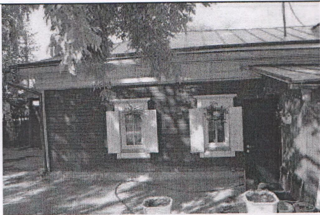
5.1. Фрагмент восточного фасада
