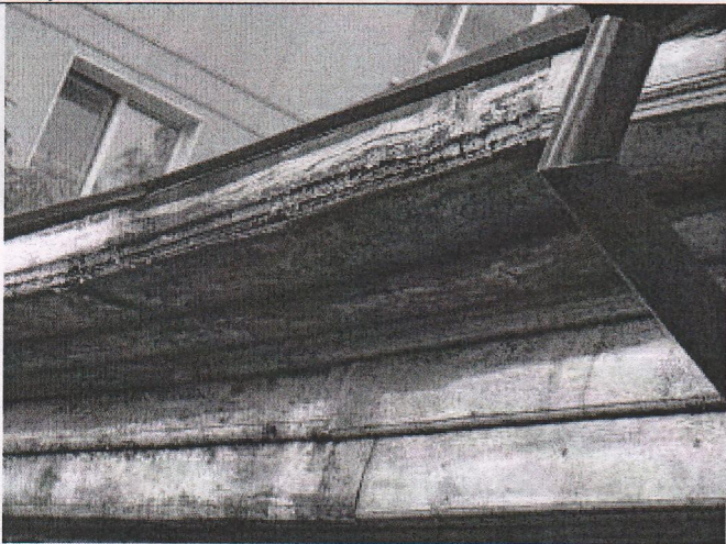
5.9. Карниз и фриз со стороны западного фасада.
