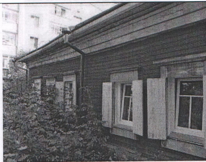
5.3. Фрагмент западного фасада
