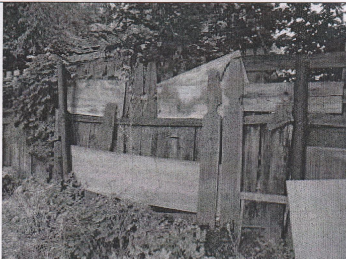
5.10. Ограждение со стороны двора
