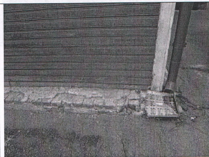
5.5. Цоколь со стороны южного фасада
