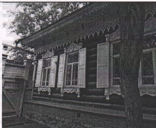
Фото № 2 Фрагмент западного фасада
