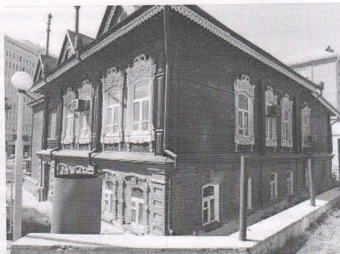
Фото 2. Северо-восточный и северо-западный фасады.
