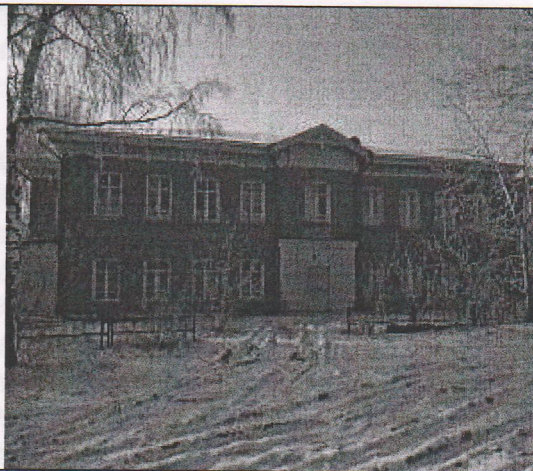
Фото № 2 Фрагмент северо-восточного фасада
