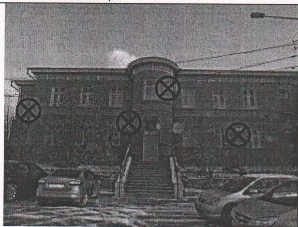
Фото № 1 Фрагмент юго-западного фасада
