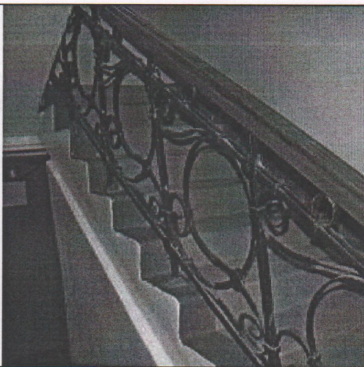
Фото № 6 Фрагмент лестницы
