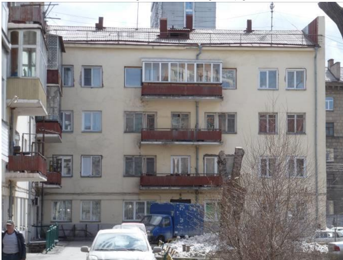
Фото 5. Северо-западный (дворовый) фасад
