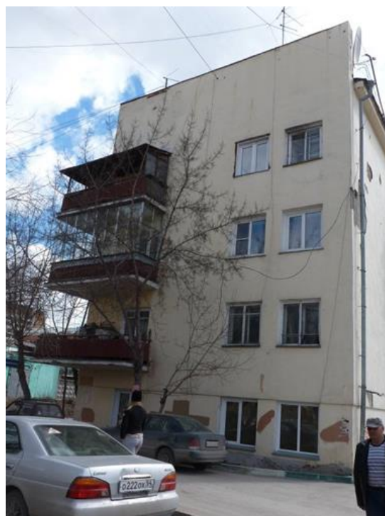
Фото 3. Северо-западный (торцевой) фасад
