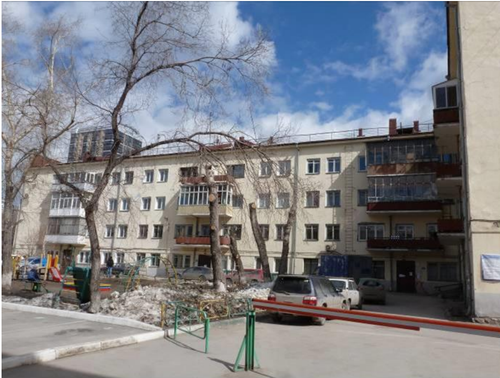
Фото 4. Юго-западный (дворовый) фасад
