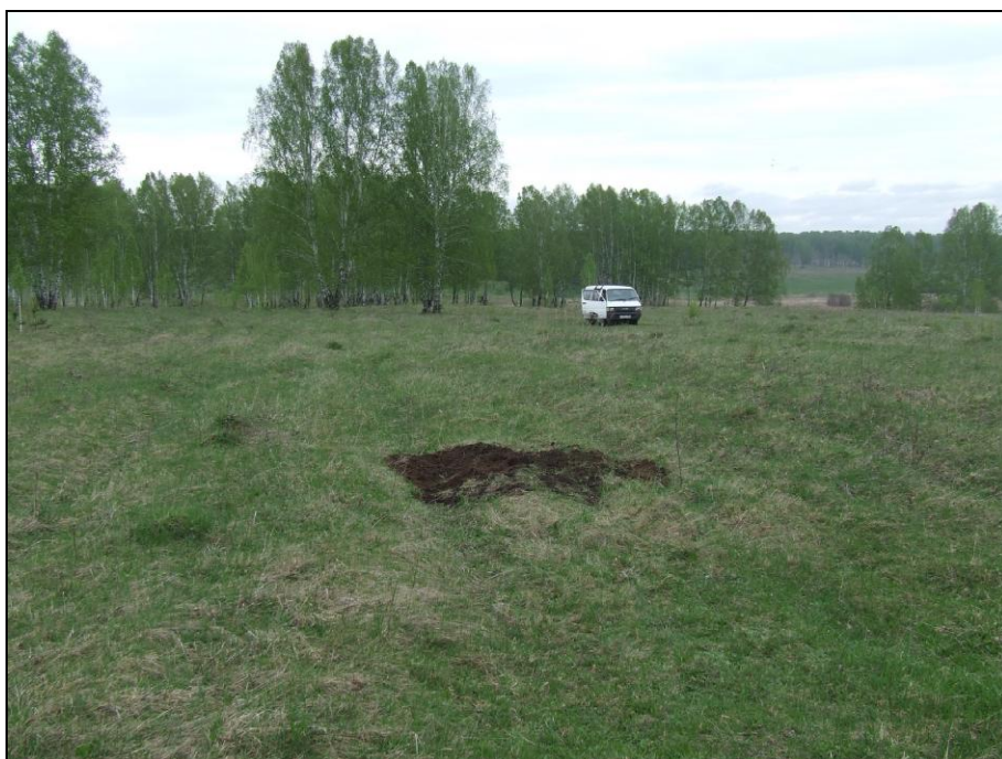
Рисунок 25. ФОТО. Строительство канализационных очистных сооружений глубокой биологической очистки в городе Болотное Новосибирской области. Разведочное вскрытие (шурф) № 2. Рекультивация. Вид с Ю.
