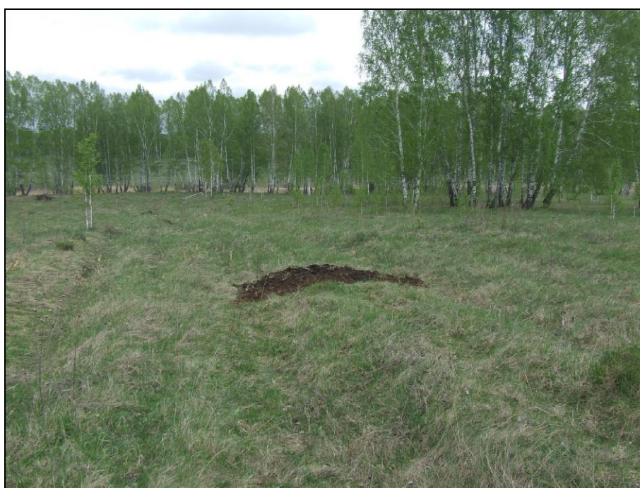
Рисунок 21. ФОТО. Строительство канализационных очистных сооружений глубокой биологической очистки в городе Болотное Новосибирской области. Разведочное вскрытие (шурф) № 1. Рекультивация. Вид с Ю.
