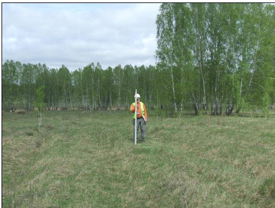
Рисунок 18. ФОТО. Строительство канализационных очистных сооружений глубокой биологической очистки в городе Болотное Новосибирской области. Вид с Ю на место закладки разведочного вскрытия (шурфа) № 1. Высота масштабной рейки 2 м.
