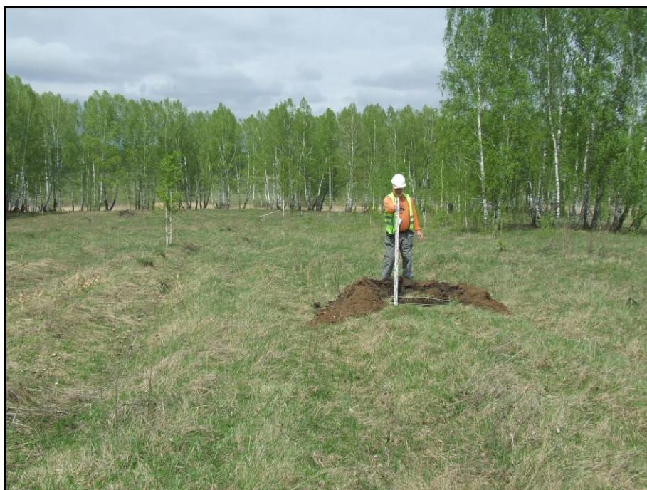
Рисунок 19. ФОТО. Строительство канализационных очистных сооружений глубокой биологической очистки в городе Болотное Новосибирской области. Разведочное вскрытие (шурф) № 1. Вид с Ю.
