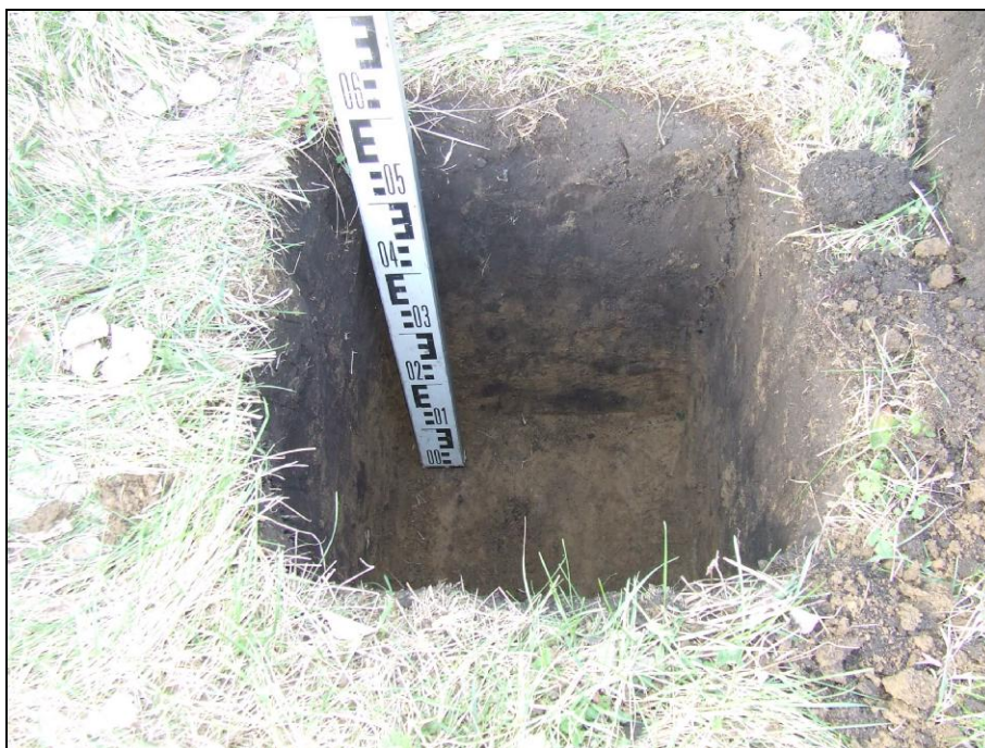
Рисунок 32. ФОТО. Строительство канализационных очистных сооружений глубокой биологической очистки в городе Болотное Новосибирской области. Разведочное вскрытие (зондаж) № 4. Вид с Ю.
