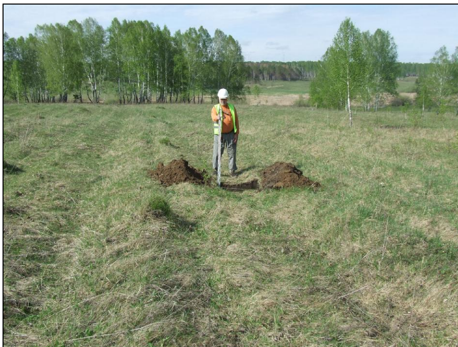
Рисунок 27. ФОТО. Строительство канализационных очистных сооружений глубокой биологической очистки в городе Болотное Новосибирской области. Разведочное вскрытие (шурф) № 3. Вид с Ю. Высота масштабной рейки 2 м.
